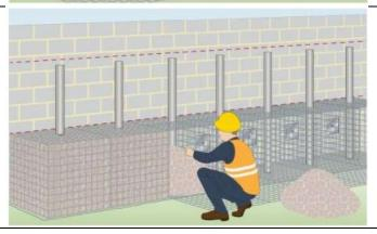
Восьмой шаг: Заполните габионы камнем. плотнее получится выкладка наполнителя, меньше между камнем пустот, тем качественнее готовая конструкция.
