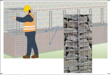
Девятый шаг: Соедините соседние габионы между собой с помощью пружин или стальной проволоки.
