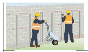
Пятый шаг: Бетонирование столбов и основания с предварительной подготовкой поверхности. Обязателен контроль уровнем для сохранения строго вертикального расположения столбов.
